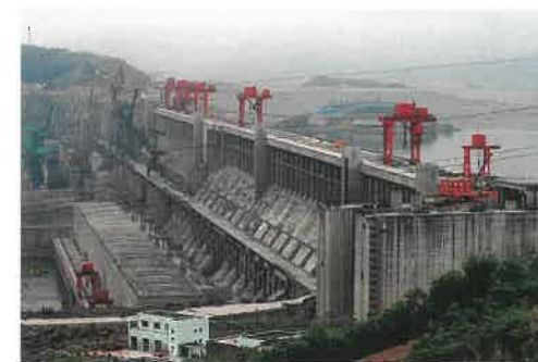
Abb. 1: Der Drei-Schluchten-Staudamm in der Bauphase Bildquelle: Wikipedia (Christoph Filnköbl)
