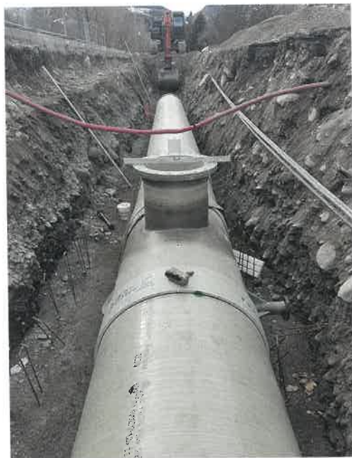
Abb. 4: Inspektionsöffnung auf 1200-mm-GFK-Rohr Foto: C. Christandl
