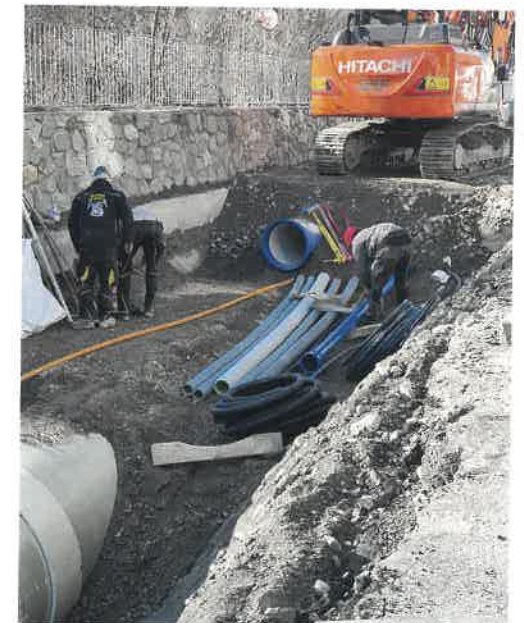
Abb. 3: Parallelverlegung von kritischen Versorgungsleitungen
