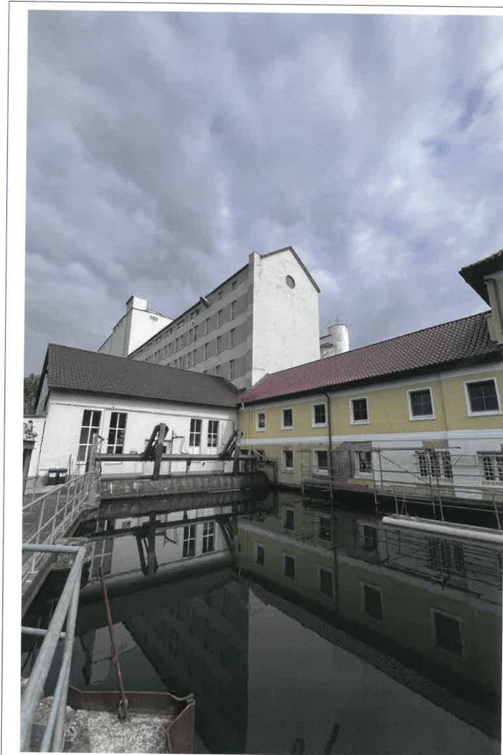
Das Wasserkraftwerk der Großen Mühle an der Innerste in Hasede-Hildesheim.
